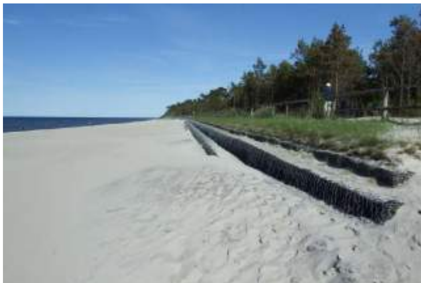
Fot. 1 Gabiony częściowo pokryte piaskiem w oczekiwaniu na sztuczne zasilanie, Jastrzębia Góra – Ostrowo, 2015 (fot. G. Różyński)
