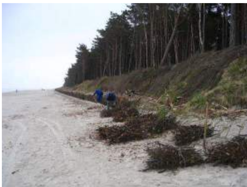
Fot. 4 Zakładanie płotków (fot. G. Różyński)
