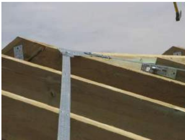
Zastosowanie systemu stężenia dachowego
